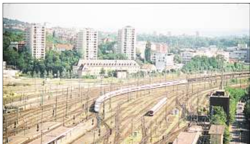
Das weite Gleisvorfeld des heutigen Bahnhofs verdeutlicht, welche Fläche den Stadtplanern zur Verfügung steht, wenn der bisherige Stuttgarter Hauptbahnhof in den Untergrund verlegt wird. Foto: Ralf Roman Rossberg
