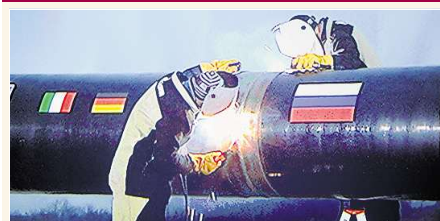
Symbolisches Schweißen der ersten Naht für die Erdgaspipeline South Stream: Im russischen Anapa am Schwarzen Meer begann Anfang Dezember symbolisch der Bau der Pipeline. South Stream soll russisches Gas zuverlässiger nach Mitteleuropa bringen als bisher. Foto: ap
