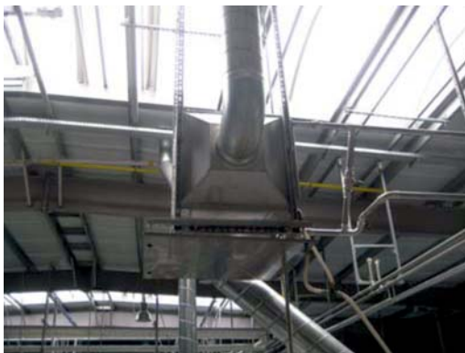
Bild 7: montierter Abluft-Wärmetauscher
